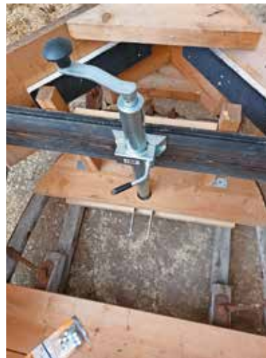
14/3: Jag har förberett och installerat "stödhjulet". Jag tog bort själva hjulet så att bara stödbenet kvarstod, och skruvade fast stödbenets klämfäste i den tvärgående plankan på plogens spets. Stödbenet tar spjårn mot en tvärgående plank mellan stöttingens medar och tar därmed "spjårn" mot stöttingen för att lyfta plogbladet. 1h
