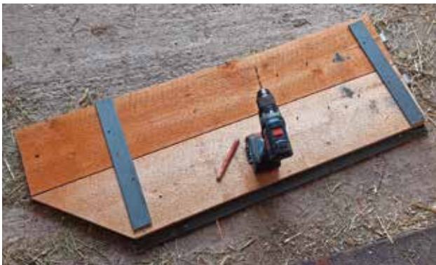
19/3: Jag har borrarat och fäst metallförstärkningar på vingarna. Här använde jag en del vagnsbult (där det var trä på framsidan), vagnsbult är snyggare och mer hållbara men passar bara där materialet är trä på den sida där bultens huvud ska sitta. På övriga ställen har jag använt skruv av passande dimension. Jag sågade även till "armar" som ska fästas i vingarna för ställbarhet i bredd. 4h
