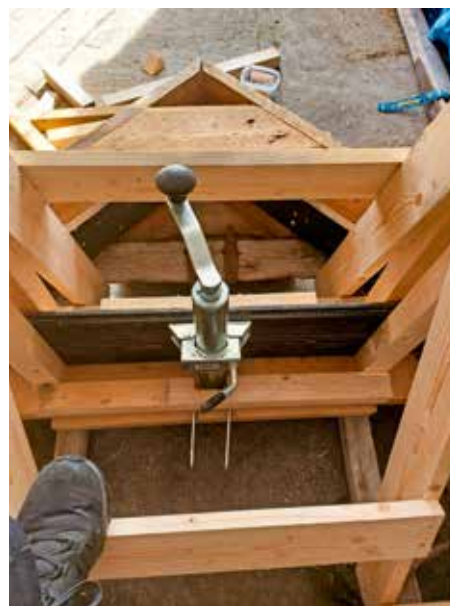
28/3: Jag har byggt träkonstruktionen till "lyftanordningen". Denna har till uppgift att hålla plogbladet och vingarna skapligt plana även vid upphissat plogblad. (Jag insåg att det blir vingligt för hela plogbladet att bara balansera på stödbenet i upphissat läge). 2h
