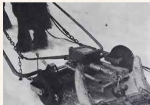
Med ett särskilt mätinstrument - en arbetsmätare - inkopplad mellan hästen och arbetsredskapet kan man bestämma det arbete hästen uträttat under en viss tid.
